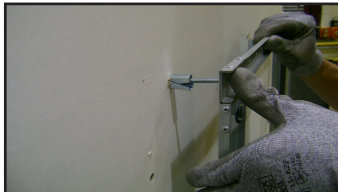
Figure 4.6 Installation des ancrages dans une cloison creuse
