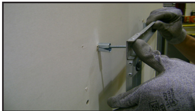
Figura 4.6 Instalación de los anclajes en una pared hueca
