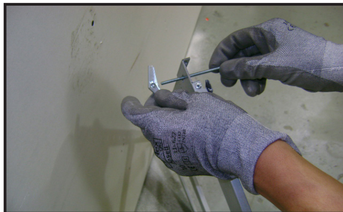
Figura 4.5 Instalación del anclaje de perno basculante a través del soporte de montaje
